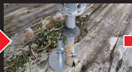
スクリー杭をジャッキアップしてから 沈下防止プレートを取り付けます。
