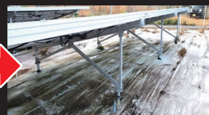
スクリー杭の沈下がおさまリ、レールの 曲がりも解消されました。
