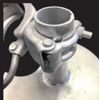
異径クランプ で接続します。
